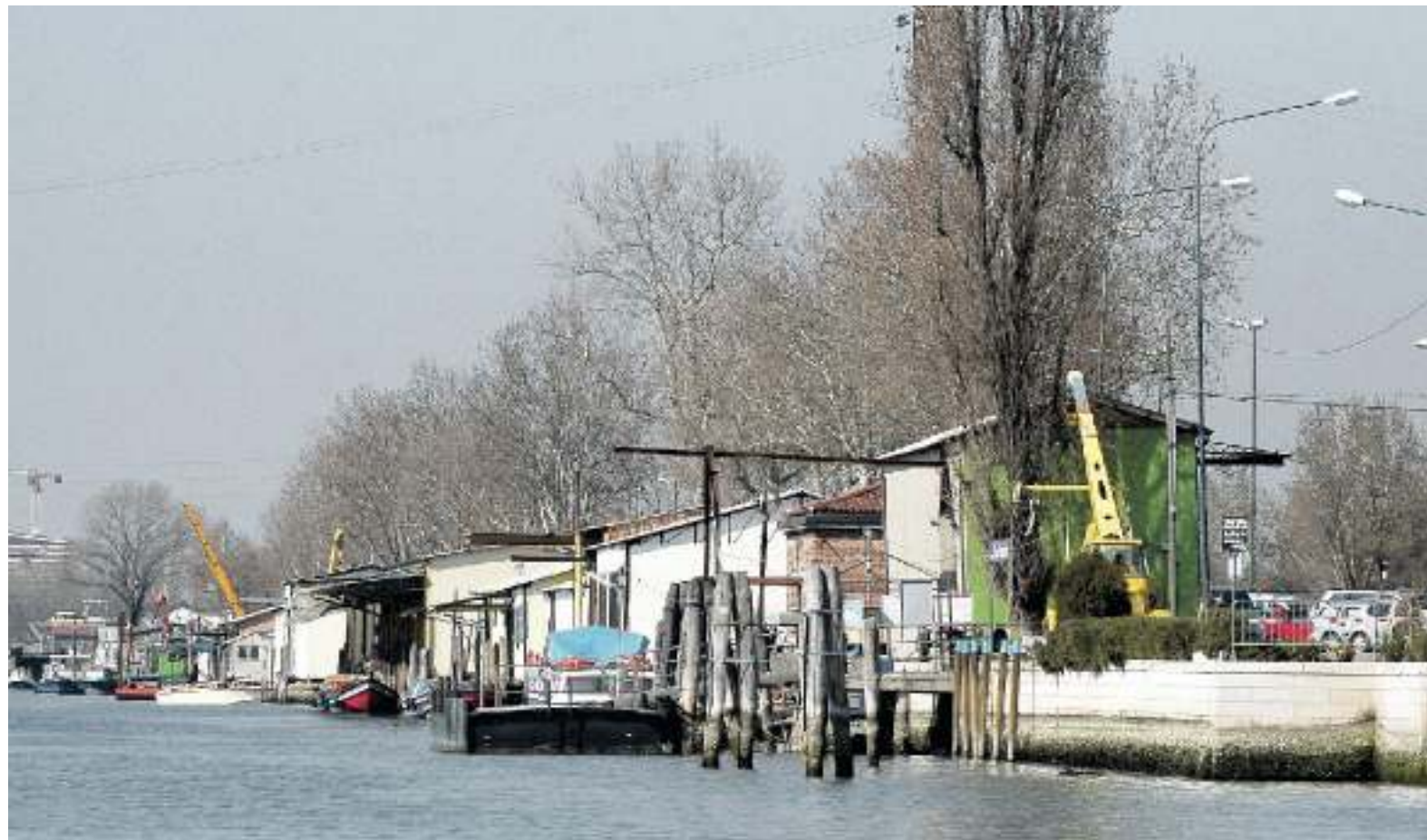
LE RIVE Il canal Salso a San Giuliano: i capannoni saranno demoliti e ricostruiti liberando spazio per il Parco
