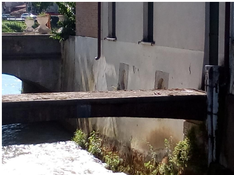
e sul lato destro i due buchi per i fusi delle ruote del mulino.
