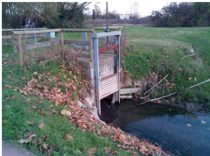
il cui diametro, all'epoca, era ulteriormente ridotto da una tavola che assicurava il mantenimento del livello dell'acqua nell'area golenale ma, in caso di pioggia, riduceva la capacità di smaltimento del tubo del 50% (la foto del 2006 mi è stata fornita da Fabrizio).
