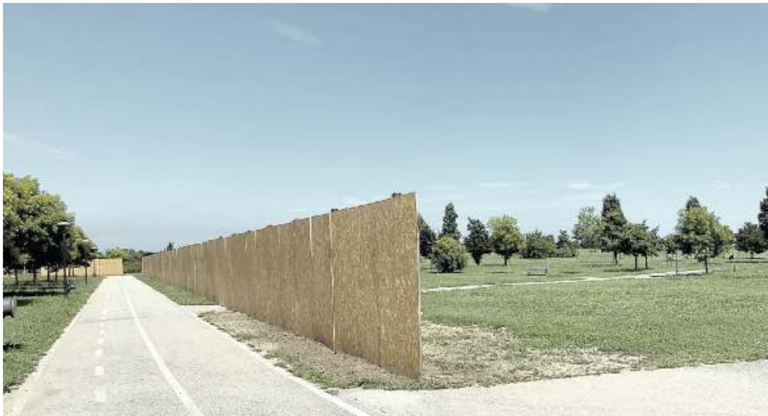
GRANDE MURAGLIA Dai primi di luglio cantiere fermo per il ritrovamento di alcuni frammenti di cemento amianto
