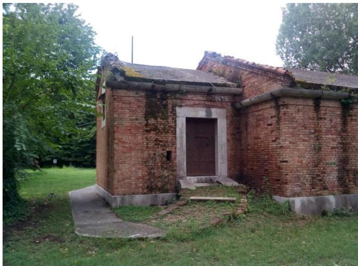
Dall'altezza dell'ingresso si capisce che il pavimento della polveriera era più alto del piano campagna in quanto era costituito da un pavimento rialzato in legno che doveva tener lontana la polvere da sparo dall'umidità del terreno.
