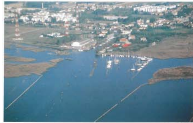
75 Argine ristrutturato del Canale di Passo Campalto
