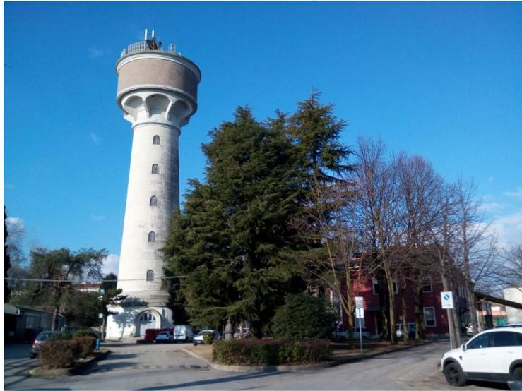
La torre piezometrica, confidenzialmente detta dividucolo è un manufatto utilizzato frequentemente negli schemi acquedottistici, composta da un serbatoio sollevato da terra da tralicci in metallo o muratura.
