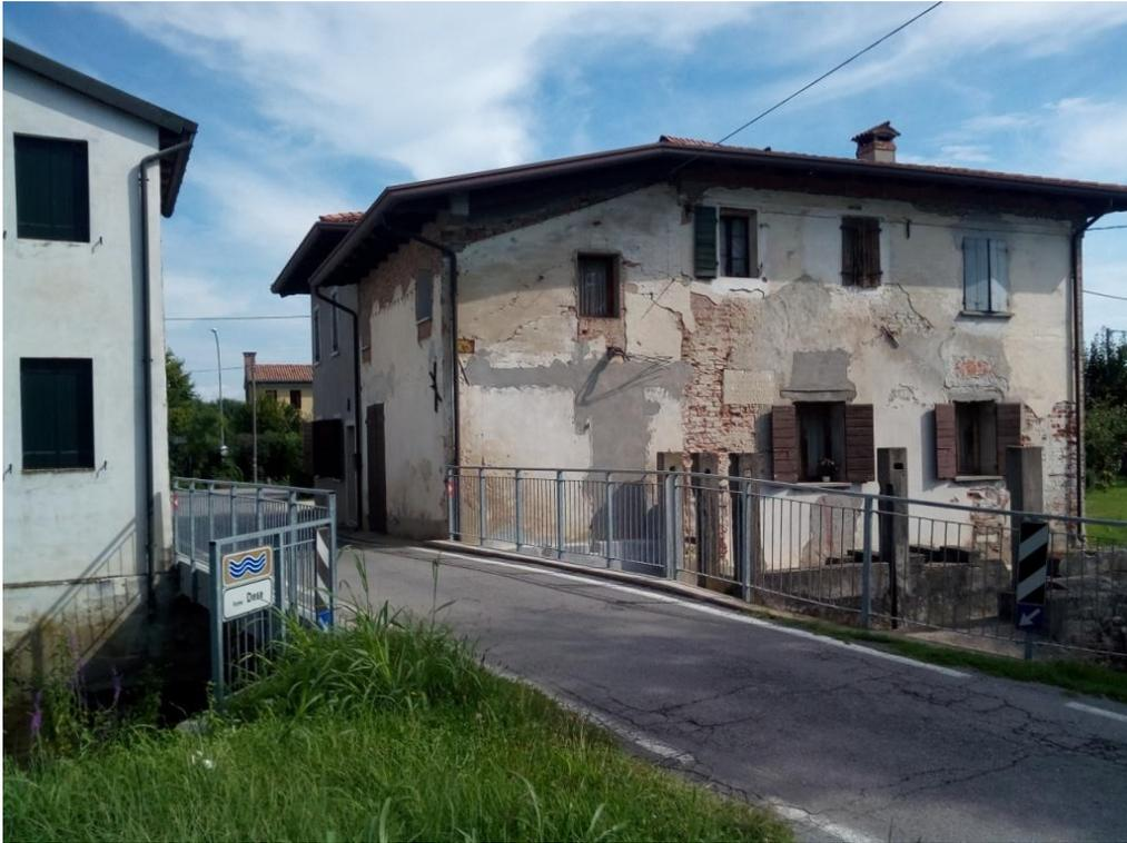
Dal ponte che passa sopra il fiume, fra il mulino ed un altro fabbricato, si vedono benissimo, a partire da sinistra, la gora della prima ruota, quella più avanzata della seconda ruota, la gora bastarda che non serviva ruote e, all'estrema destra, si intravede anche lo scolmatore destinato a deviare l'acqua in eccesso per l'attività del mulino.
