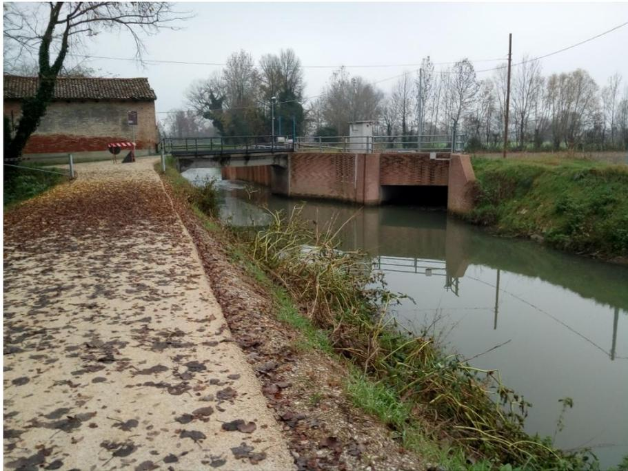
In questo modo la sezione idraulica del salto d'acqua e del by pass sono equivalenti a quella a monte rendendo possibile far transitare la stessa portata e riducendo così i possibili fenomeni di esondazione.
