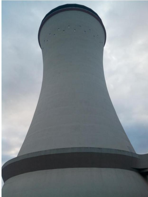
La Torre, di tipo Van Iterson, è una iperbolica con un diametro di 25 metri alla base che si restringe fino a 16 metri al centro per poi riallargarsi fino a raggiungere i 54 metri di altezza.
