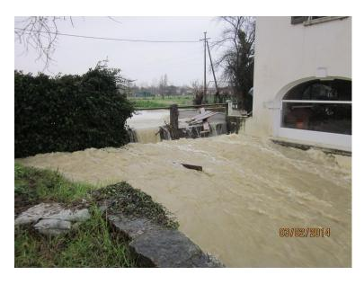
La foto rende evidente quanto fossero necessari i bypass, realizzati quattro mesi dopo, per evitare la tracimazione dell'acqua in corrispondenza della strozzatura del mulino.
