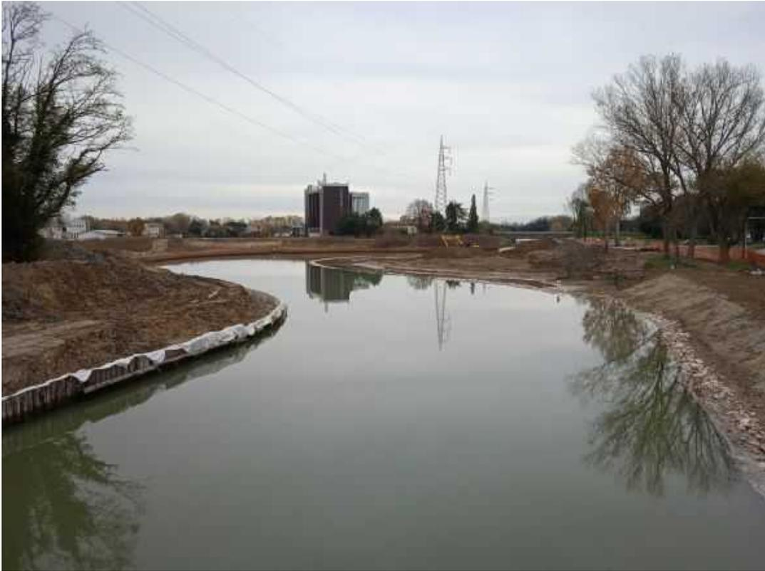
La sinistra idraulica ha una sponda di circa un metro su cui si apre il piccolo varco dello scivolo per il varo delle barche mentre la destra idraulica si presenta rilevata di pochi centimetri rispetto al livello del fiume.
