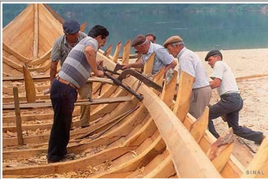
Após a colocação destes reforços transversais interiores passam a tratar dos reforços de bordadura, ou seja das guarnições. A borda é cintada por fora com os verdugos, terminados à proa e à ré pelos curvatões, e no interior com as dragas. Muitas vezes usavam o fogo para encurvar estas peças.
